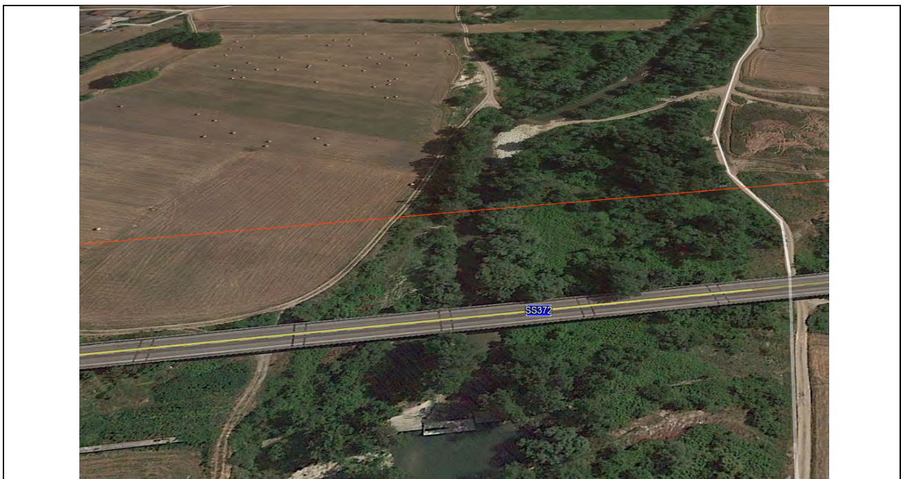
Fig. 2.52 – Attraversamento del Torrente Titerno Condotta Acquedotto di Integrazione ACAM
