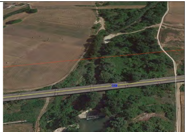
Attraversamento del Torrente Titerno da parte della condotta di Integrazione ACAM
