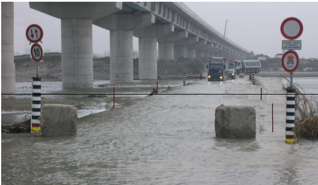
Esempio di segnaletica da applicare in prossimità di un guado
