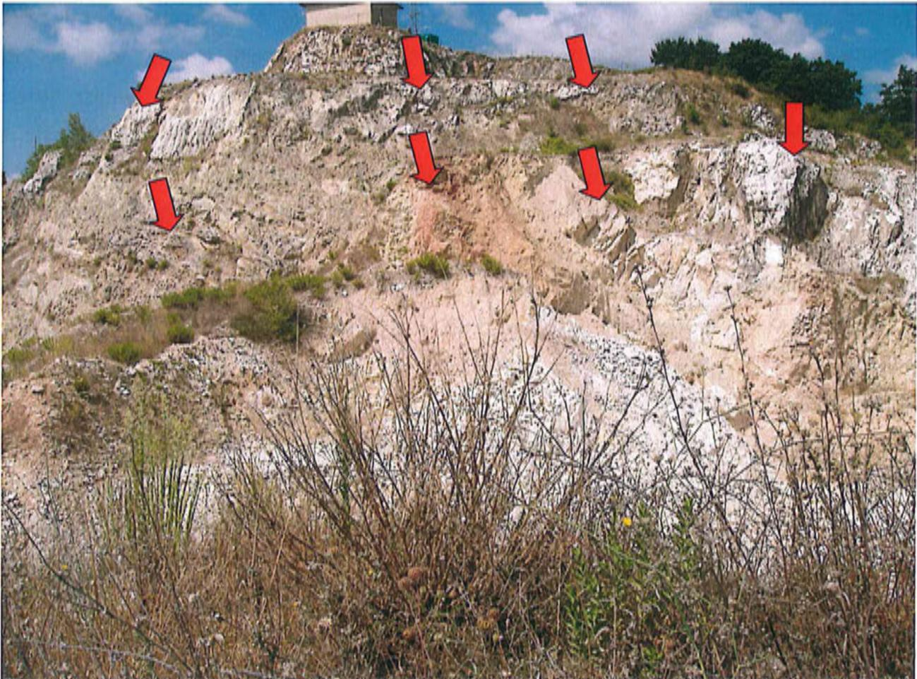
Foto 1 Particolare del fronte di cava la cui sommità è impegnata dal serbatoio idrico. Le frecce indicano i massi pericolanti e potenzialmente instabili, oggetto di bonifica.
