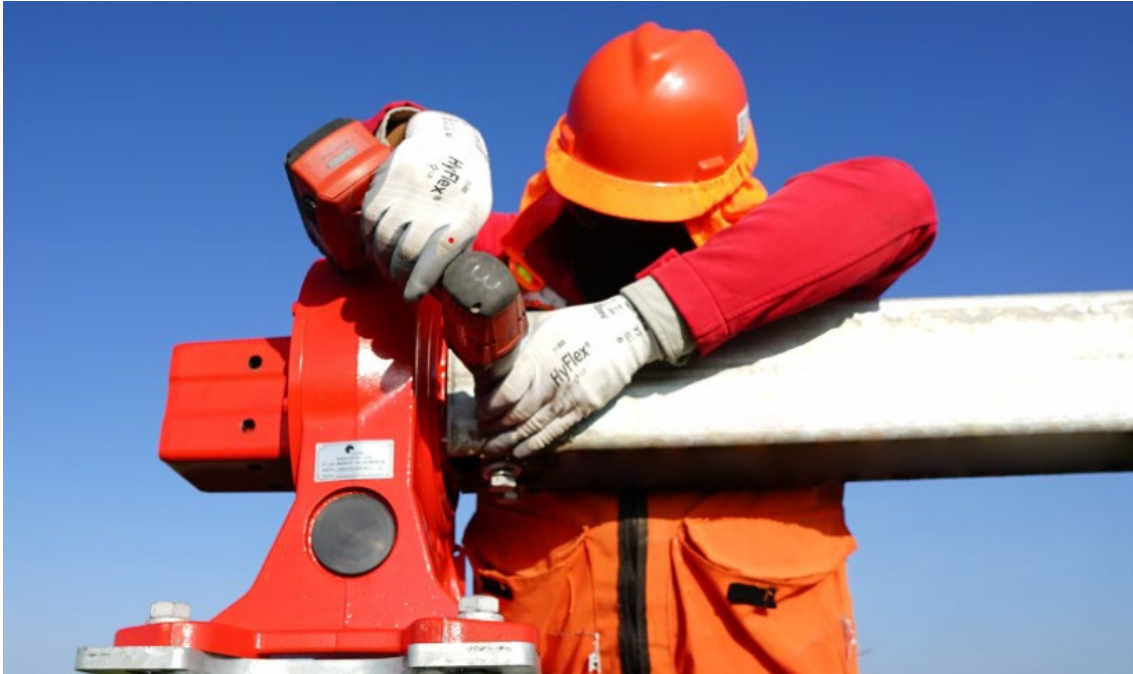
Figura 4 - fase montaggio tracker
