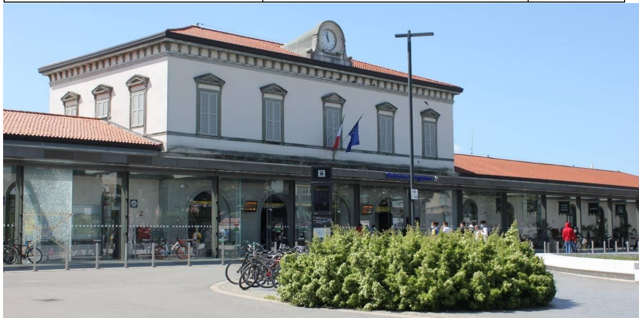
Figura 3. Vista esterna Fabbricato Viaggiatori - Stazione di Bergamo
