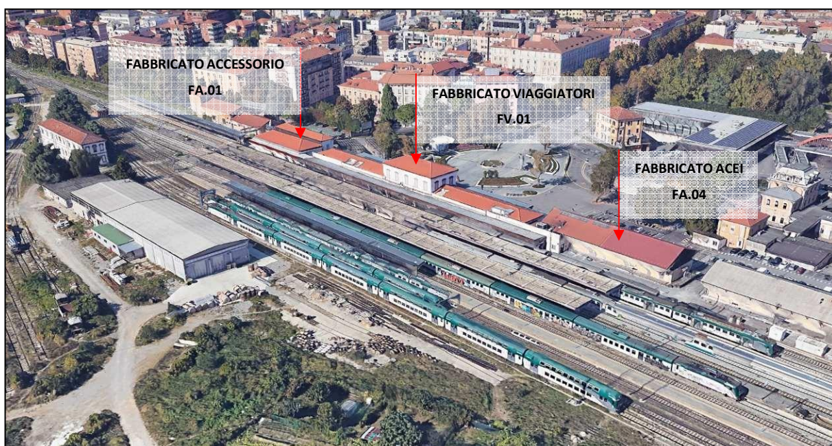
Figura 5. Vista d'insieme con individuazione Fabbricato ACEI ( FA.04)
