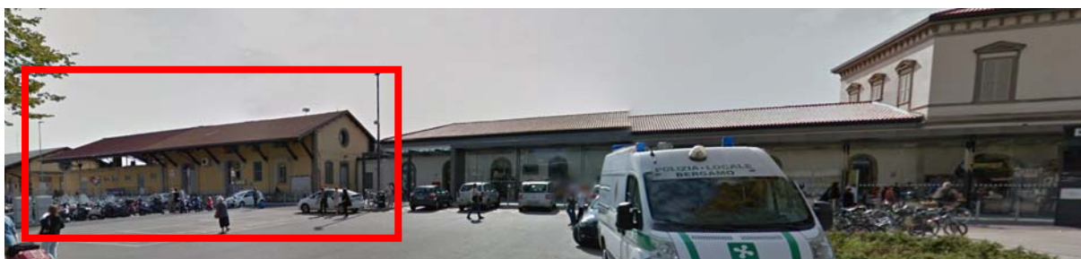
Figura 10 Edificio da demolire
