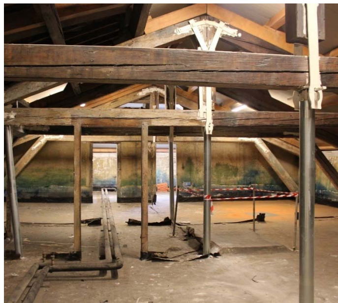
Figura 28_Vista piano sottotetto FV
