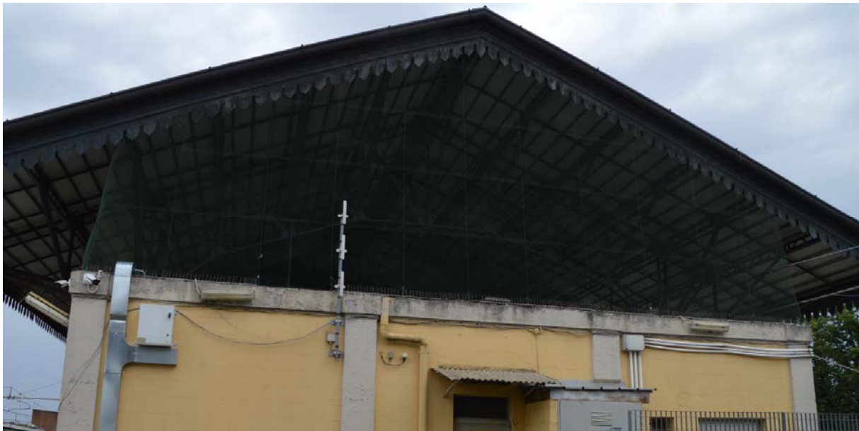
Figura 32_Vista Fabbricato Ex MM
