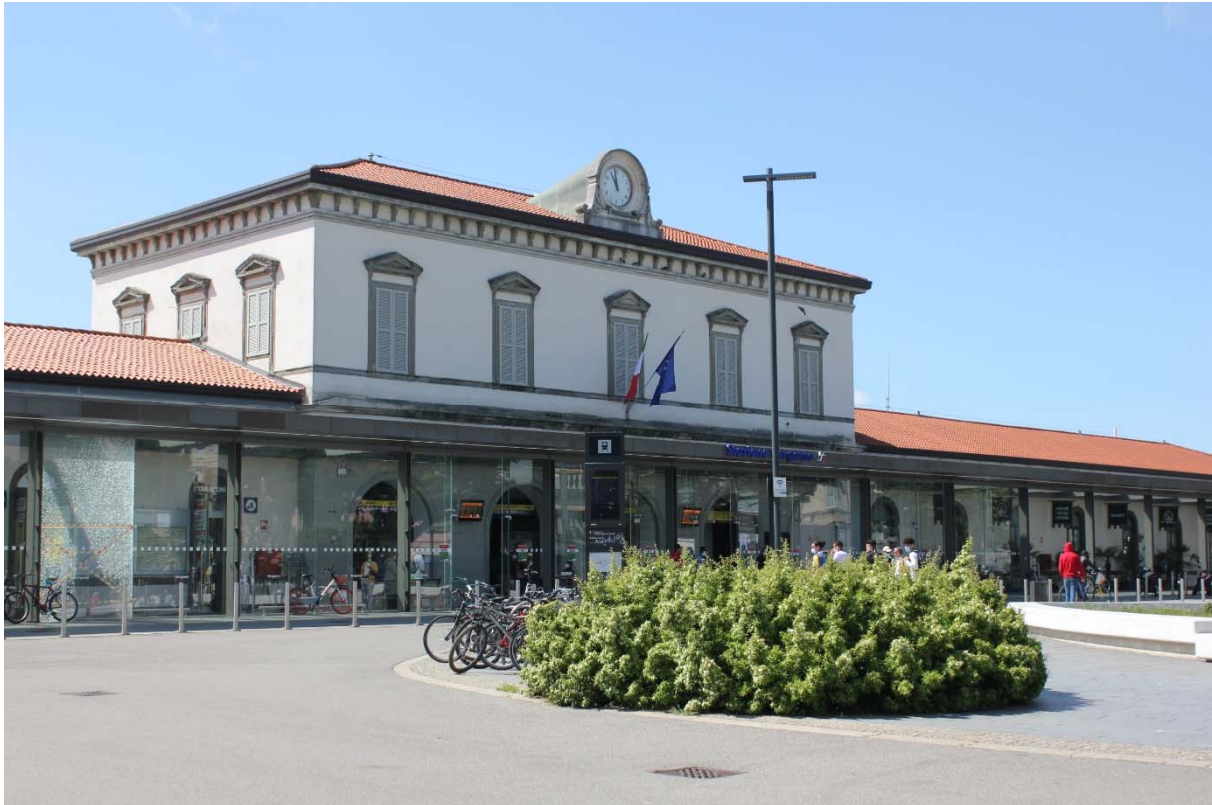
Figura 18 Fabbricato Viaggiatori - Stazione di Bergamo
