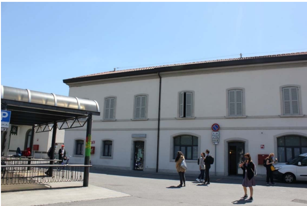
Figura 29_Vista esterna Fabbricato Alloggi
