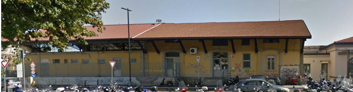
Figura 31_Vista Fabbricato Ex MM
