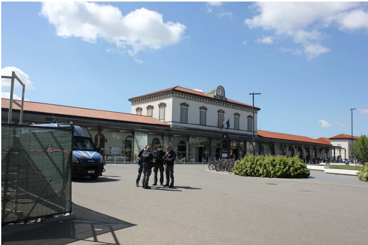
Figura 25_ Vista Fabbricato viaggiatori da Piazza Marconi
