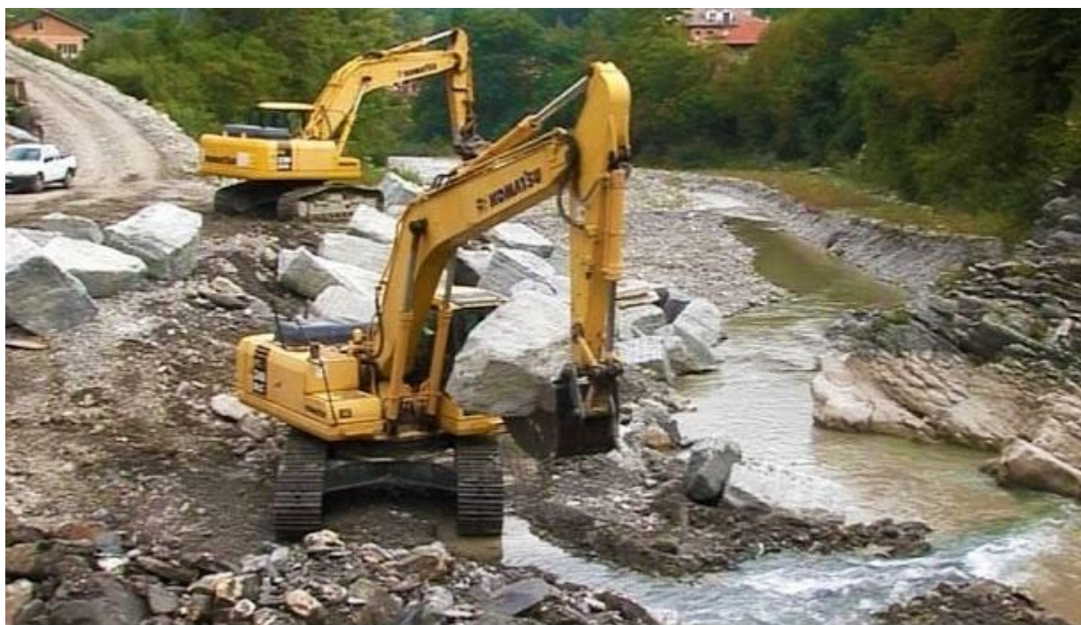
Figura 6.3.2 - Esempi di attività di scavo in alveo tramite escavatori cingolati a braccio rovescio
