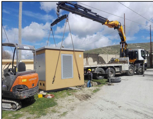
Figura 7 - Fasi di scarico cabine prefabbricate in cav
