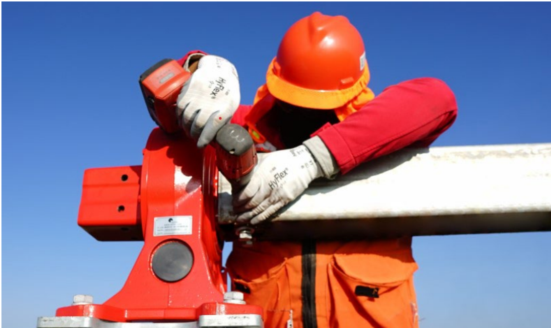
Figura 4 - fase montaggio tracker
