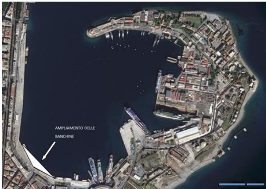
Figura 3: Foto aerea del Porto di Messina – Ipotesi d’ampliamento delle banchine esistenti
