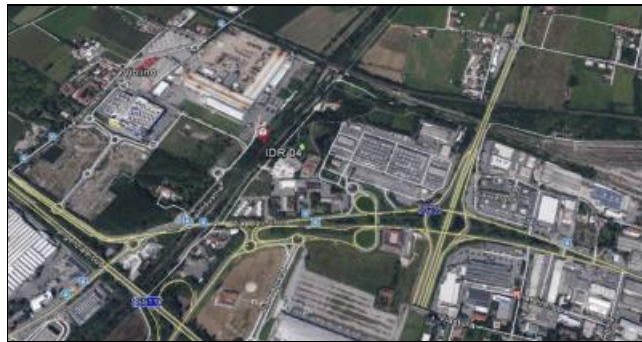
SITO IDR 04 AEREA
