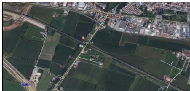
SITO IDR 01 AEREA
