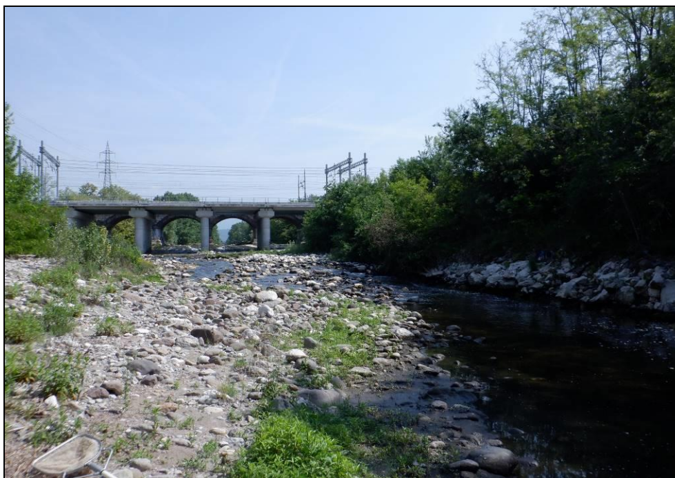
Foto 1.1 – Fiume Mella a valle del nuovo ponte della LINEA AV/AC, maggio 2022
