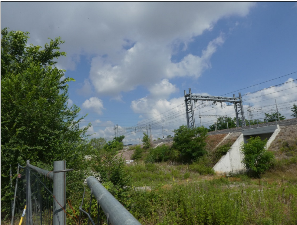
Panoramiche dell'area di cantiere
