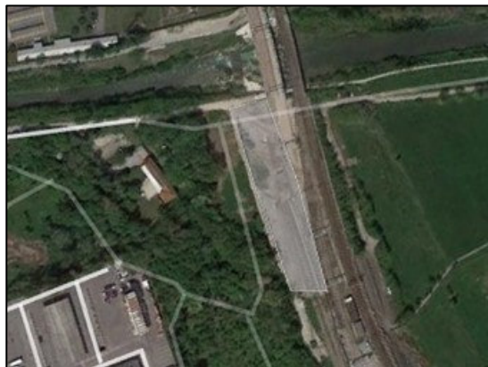
Localizzazione dell'area di cantiere posta a monte della linea ferroviaria
