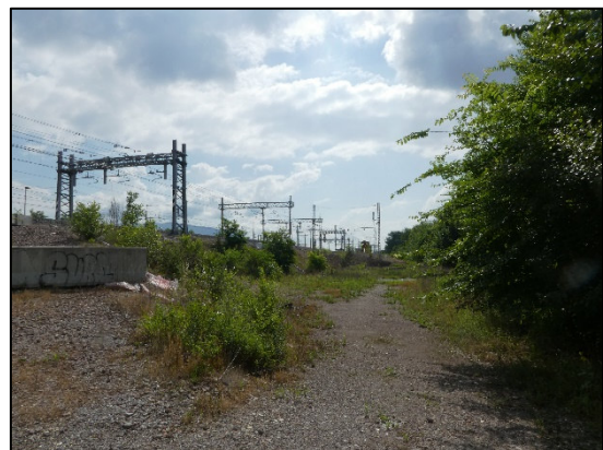
Veduta area cantiere
