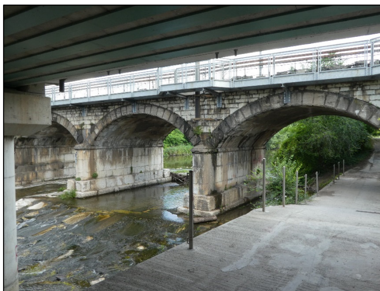
Panoramiche dei ponti sul fiume Mella
