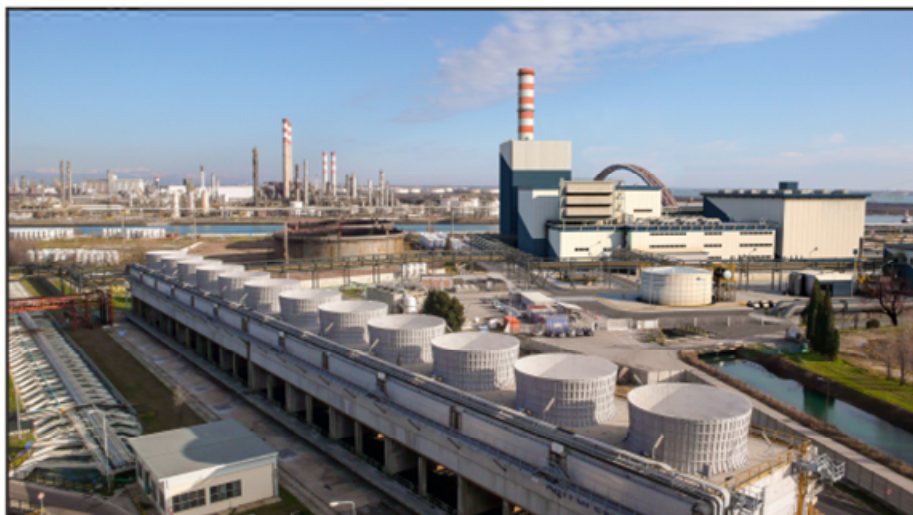
Figura 5. Nuova unità a gas con solo camino CCGT
