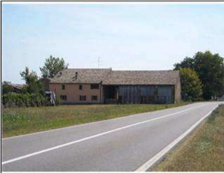
Vista da: Nord
