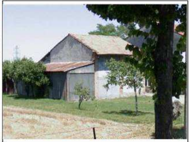
Vista da: Ovest
