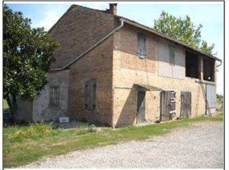
Vista da: Nord
