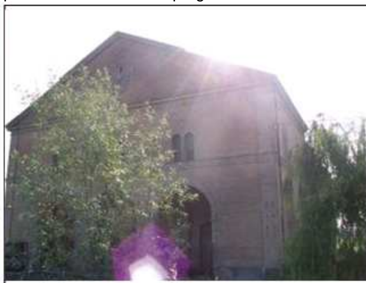
Vista da: Ovest
