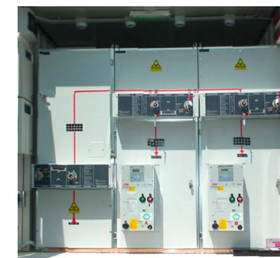
Tensione Vcc = 230V
