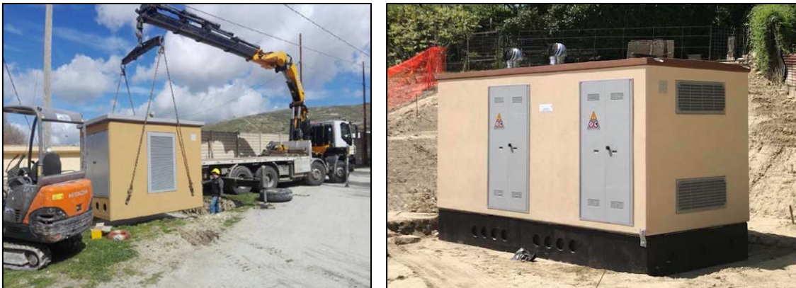
Figura 7 - Fasi di scarico cabine prefabbricate in cav
