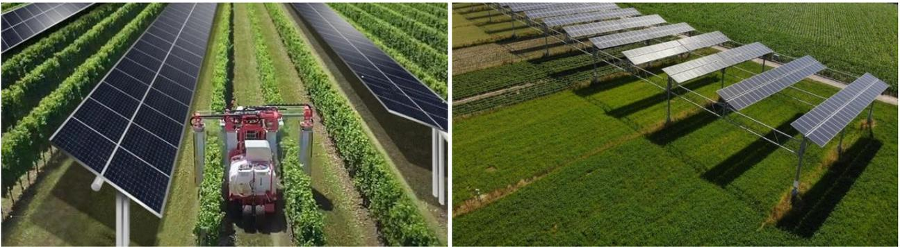
Figura 8 - Particolare di un inseguitore monoassiale est-ovest in un sistema agro-fotovoltaico
