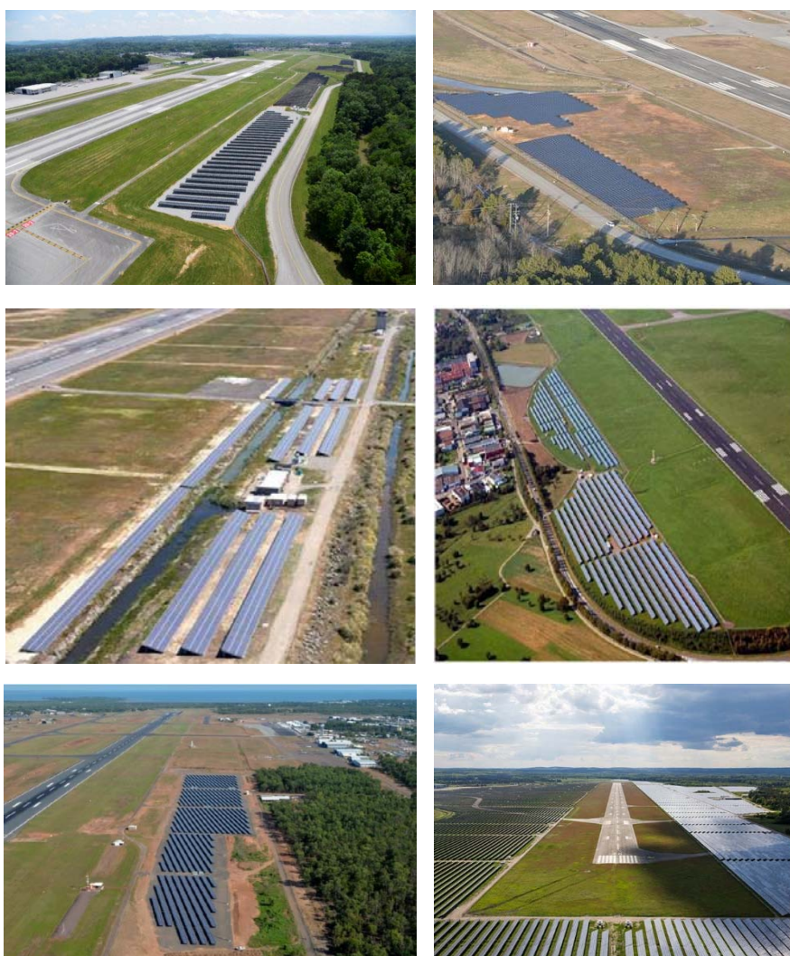
Figura 5: Esempi di impianti fotovoltaici in ambito aeroportuale. La disposizione dei moduli fotovoltaici in prossimità delle piste di atterraggio/decollo non rappresenta un rischio per la sicurezza.
