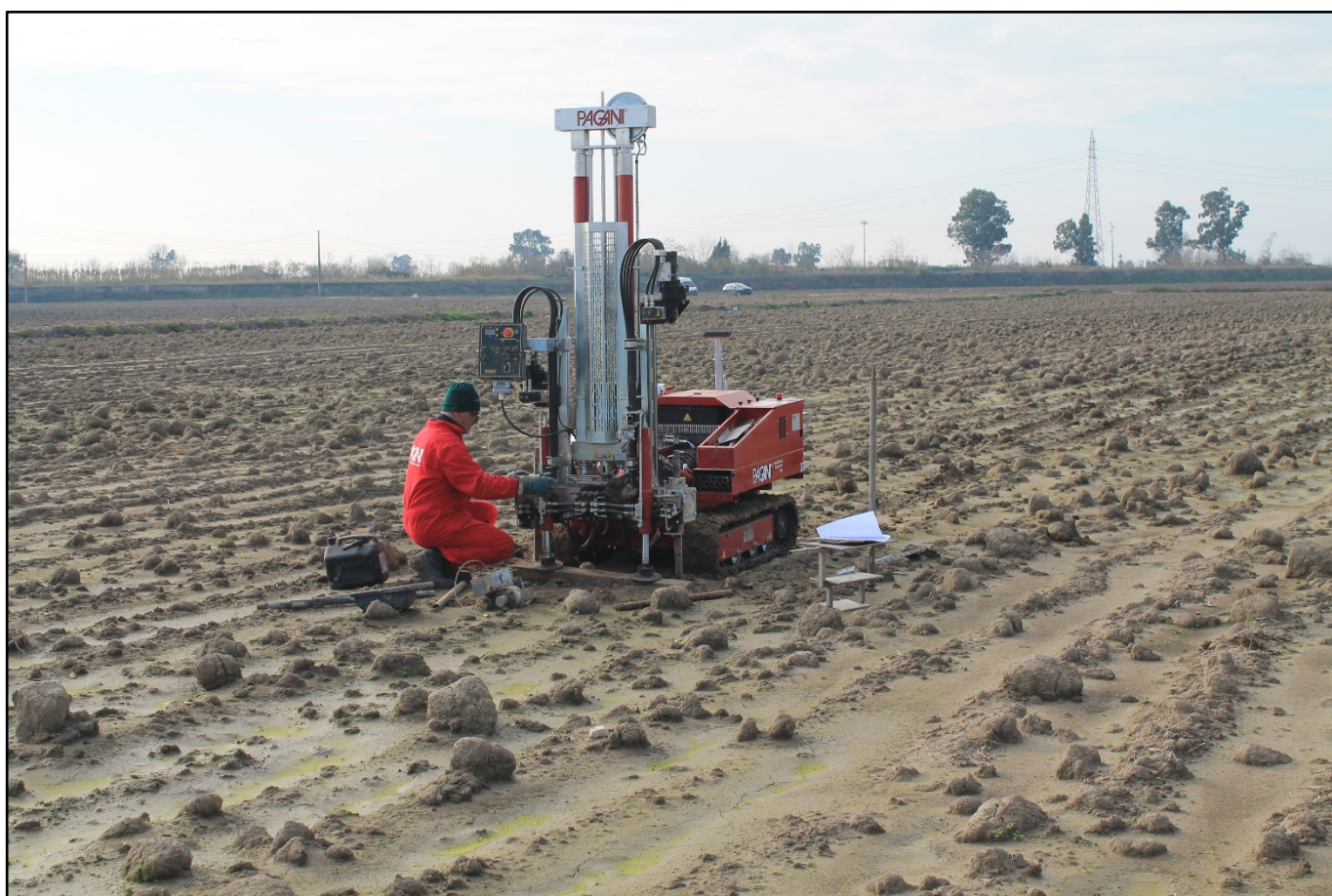
Foto 3 – Ubicazione della prova penetrometrica statica CPT1
