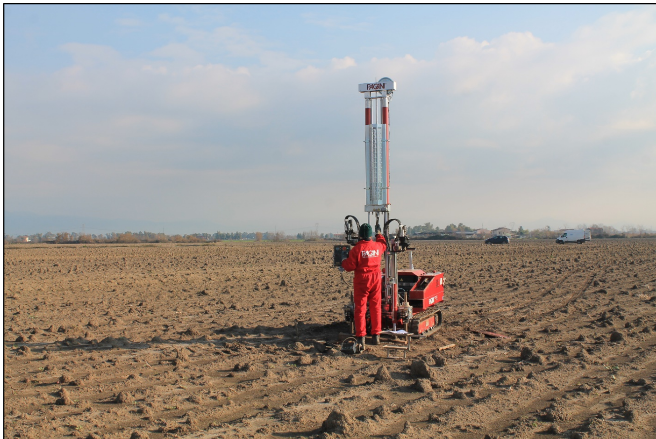
Foto 4 – Ubicazione della prova penetrometrica statica CPT2
