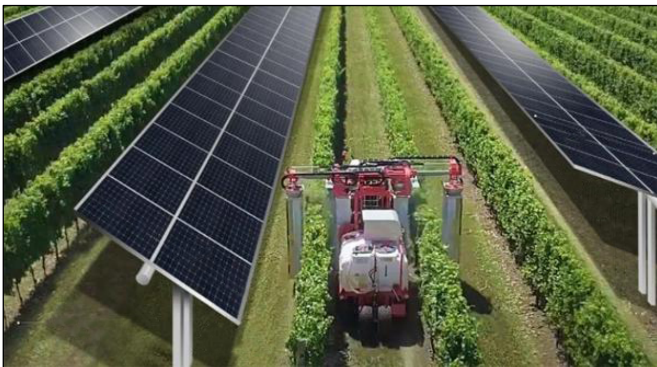
Fig. 6 – Particolare di un inseguitore monoassiale est-ovest in un sistema agro-fotovoltaico
