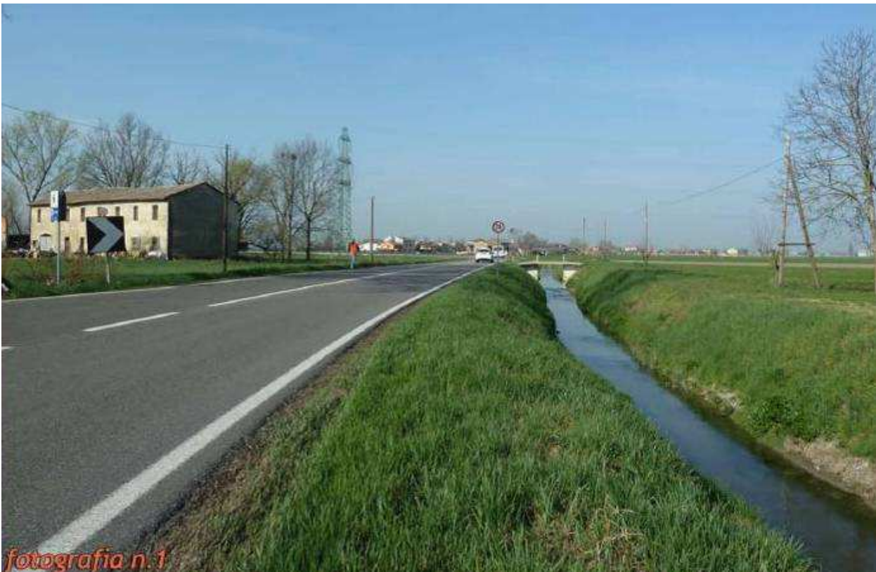
FIGURA 1-1- FOTOGRAFIA SCATTATA AD EST IN LOCALITA' CERTOSINO PRESSO L'AREA IN CUI SARA' REALIZZATA LA ROTATORIA, CON PARTICOLARE DEL CAVO BURLA
