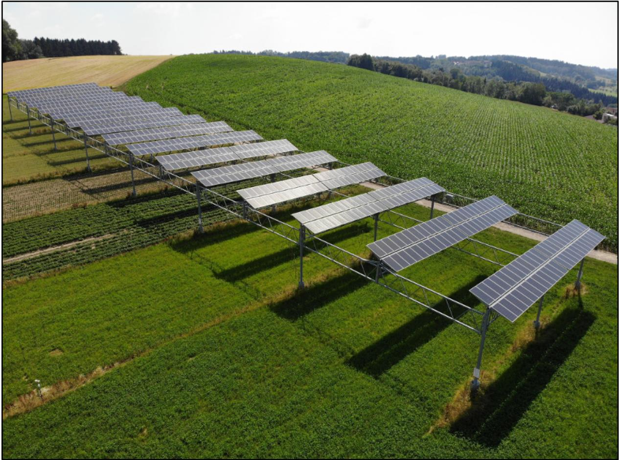
Fig. 3 – Particolare di un inseguitore monoassiale est-ovest in un sistema agro-fotovoltaico
