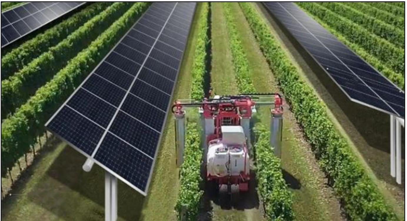
Fig. 2 – Particolare di un inseguitore monoassiale est-ovest in un sistema agro-fotovoltaico
