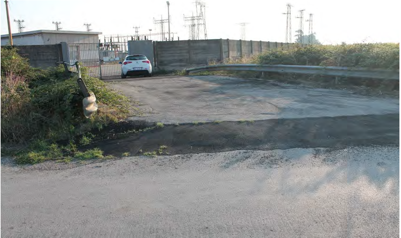
Strada ingresso alla CP Castelvolturno
