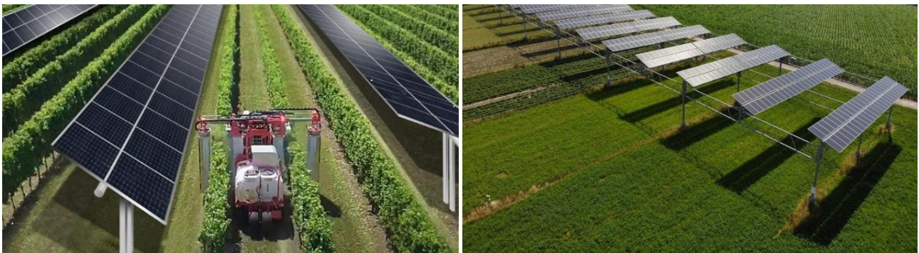
Particolare inseguitore monoassiale est-ovest in un sistema agrivoltaico
