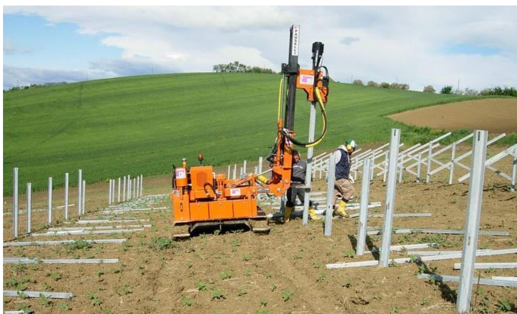
Macchina battipali per l'ancoraggio delle strutture che non richiede opere di scavo
