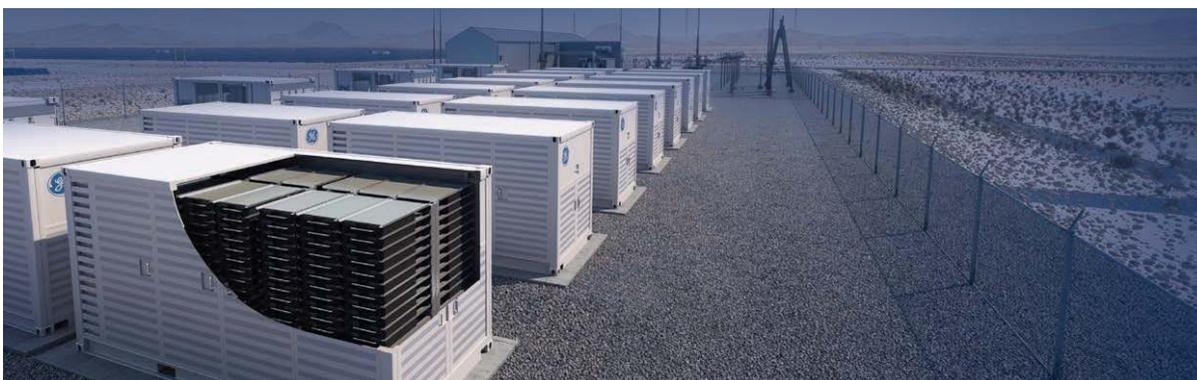
**I sistemi di accumulo sono composti da batterie al LITIO, alloggiati in container standard ISO 20'.**
