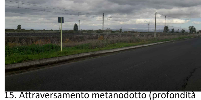
15. Attraversamento metanodotto (profondità tra 4.75m e 3.70m)
