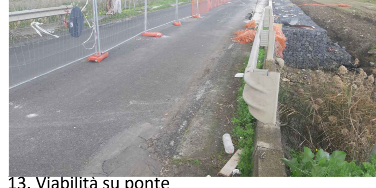
13. Viabilità su ponte
