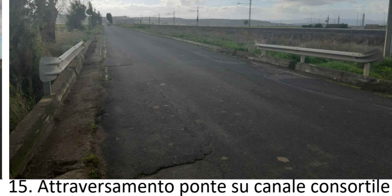
15. Attraversamento ponte su canale consortile tra 4.75m e 3.70m
