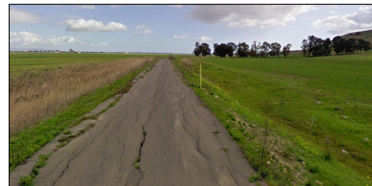
10. Attraversamento metanodotto (profondità metanodotto tra 5.30m e 5m)
