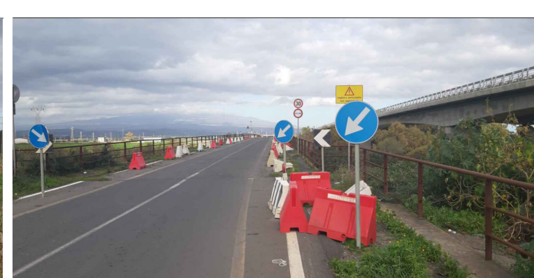
23. Viabilità su ponte sopra fiume Simeto
