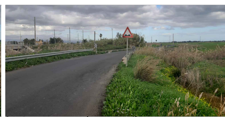
21. Ponte su canale consortile
