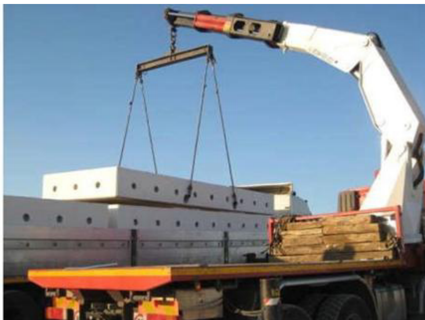
Figura 22 | Scarico cabina trasformazione
