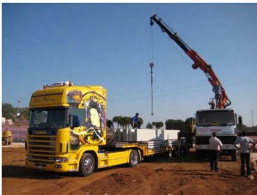
Figura 21 | Attività di scarico cabina di campo
