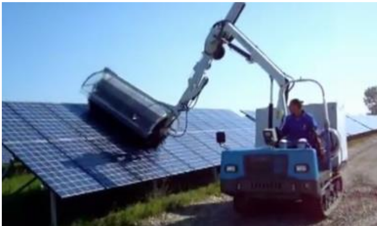
Immagine 13 macchina lavaggio pannelli su impianto fisso
