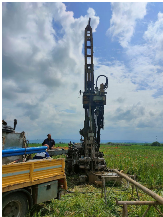
Figura 3: Esecuzione prova SPT.
