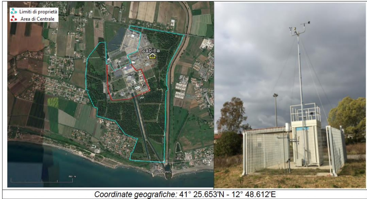
Figura 2 - Ubicazione della cabina di monitoraggio nell’area SOGIN
