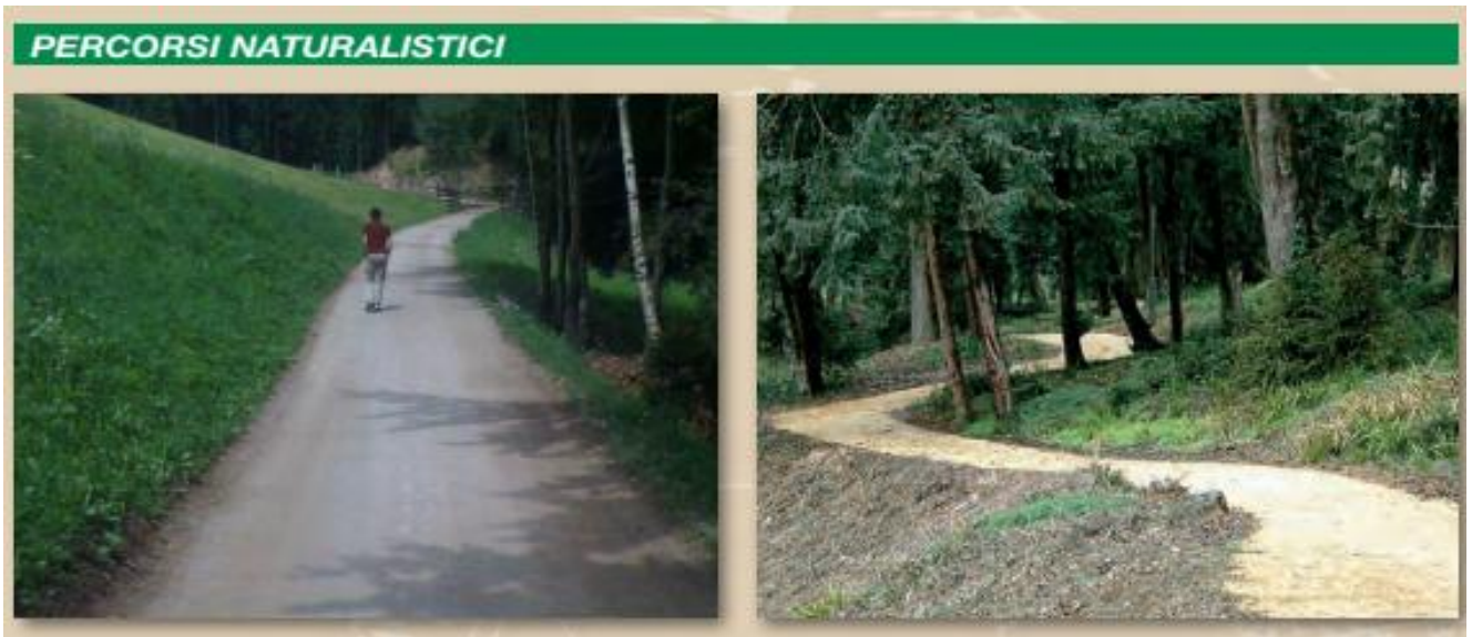
Figura 20: Esempi di strade realizzate in terra stabilizzata in percorsi naturalistici.
