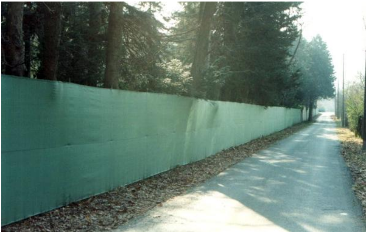
Figura 21: Esempio applicazione di reti antipolvere e frangivista.
