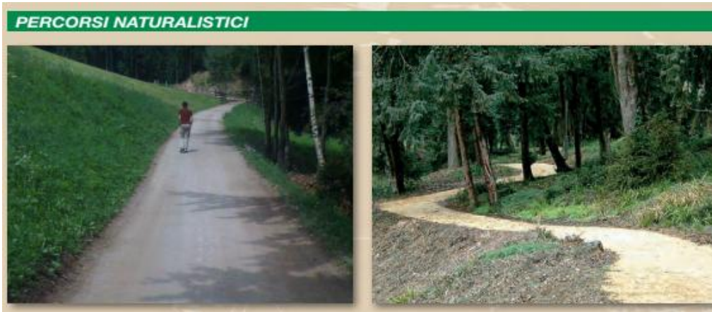
Figura 115: Esempi di strade realizzate in terra stabilizzata in percorsi naturalistici.
