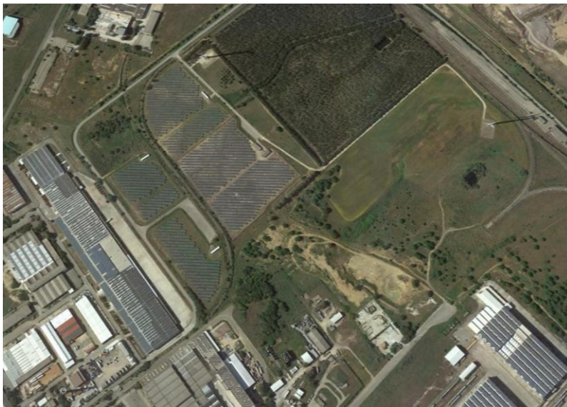
Figura 44: Foto aerea impianto n. 4.
