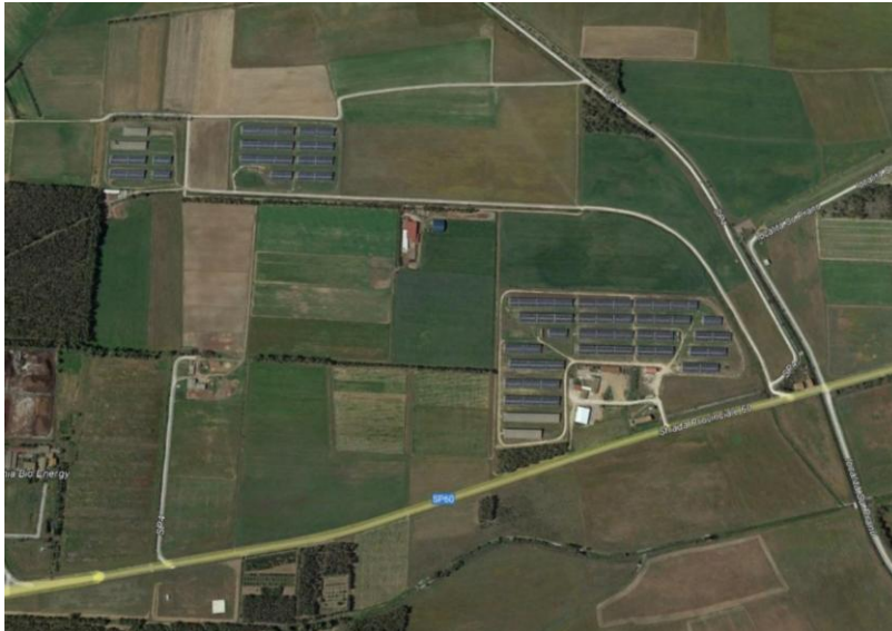
Figura 45: Foto aerea impianto n. 5.
