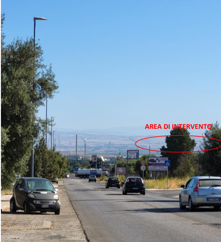
Figura 83: Vista da PB E post intervento.
