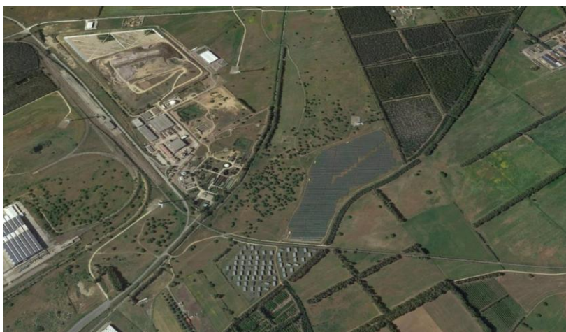
Figura 40: Foto aerea impianto n. 1.
