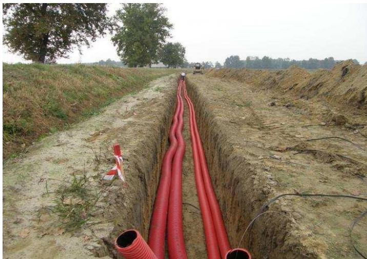
Figura 31: Scavo tipo per posa cavidotto.
