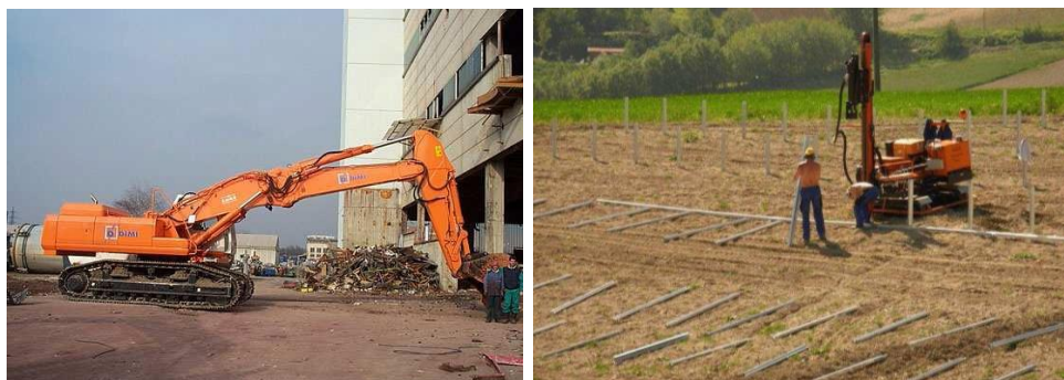
Figura 7: Esempi di macchine operatrici impegnate per la costruzione dell'impianto (Escavatore e macchina battipalo o avvitatore).
