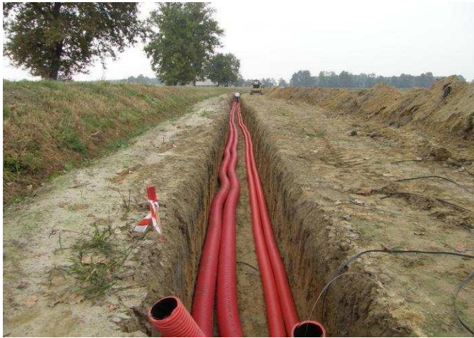
Figura 15: Scavo tipo per posa cavidotto.
