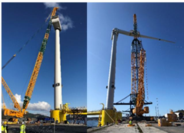
**Figura 3.18 Installazione della turbina eolica sulla piattaforma galleggiante.**
