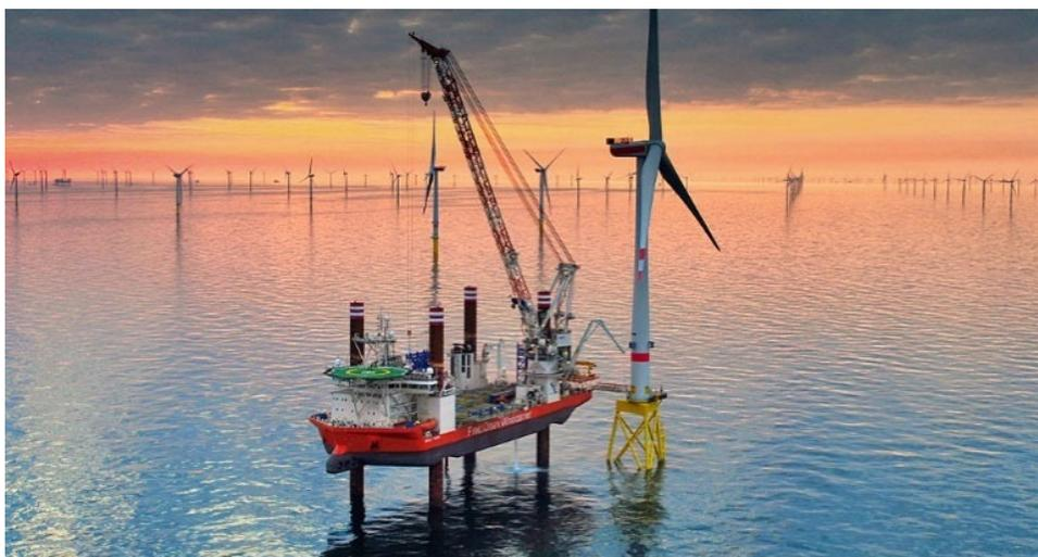
**Figura 3.17: Installazione di una turbina.**
