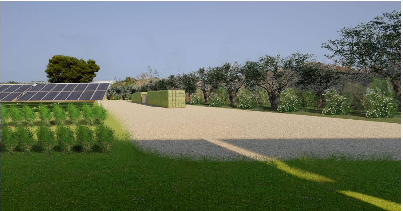
Figura 21 – Vista interna dell'impianto agrivoltaico
