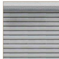
Particolare lastra di rivestimento in cemento con finitura a vista: motivo rigato orizzontale
