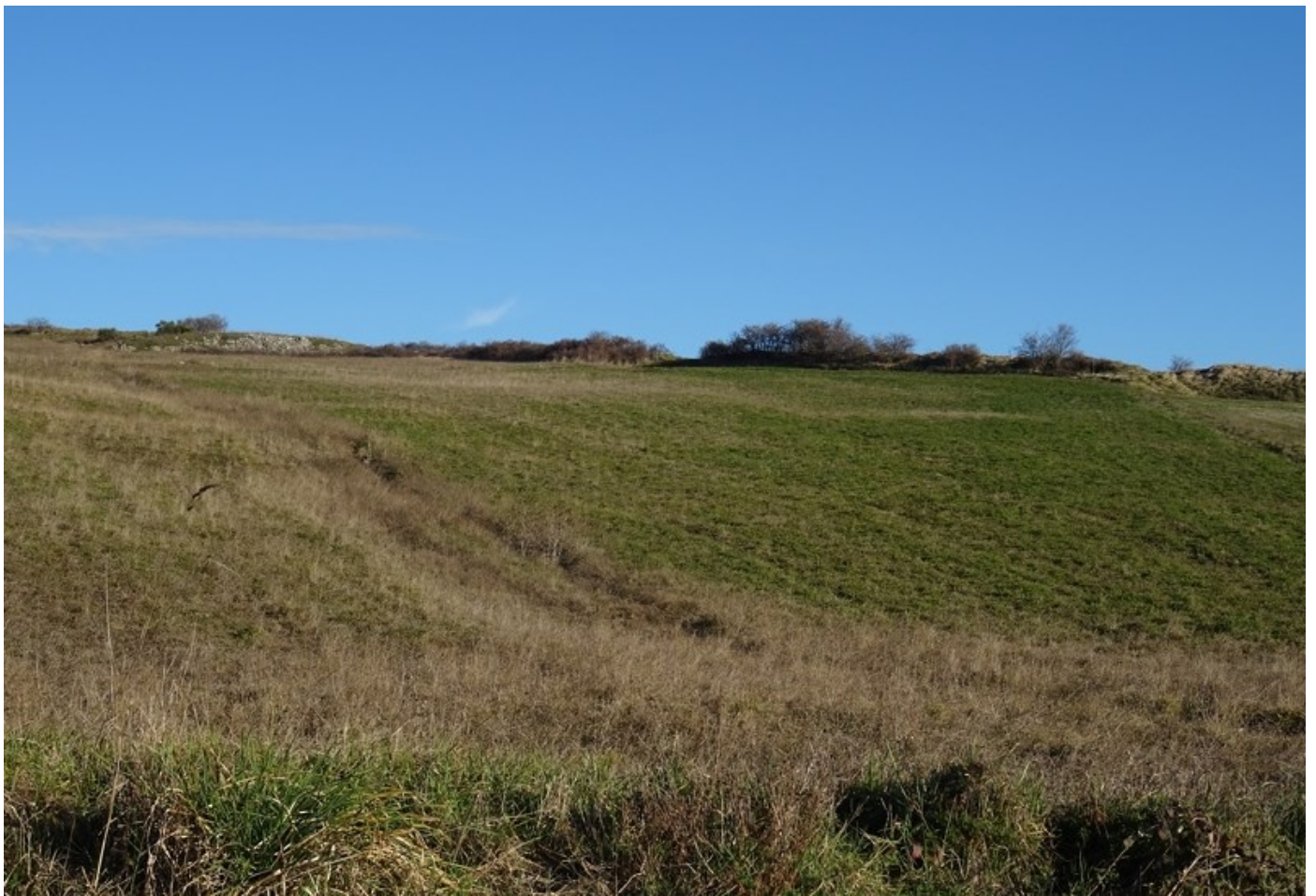
Foto 224 – Panoramica della frana posta est della “Casa de Luca”
