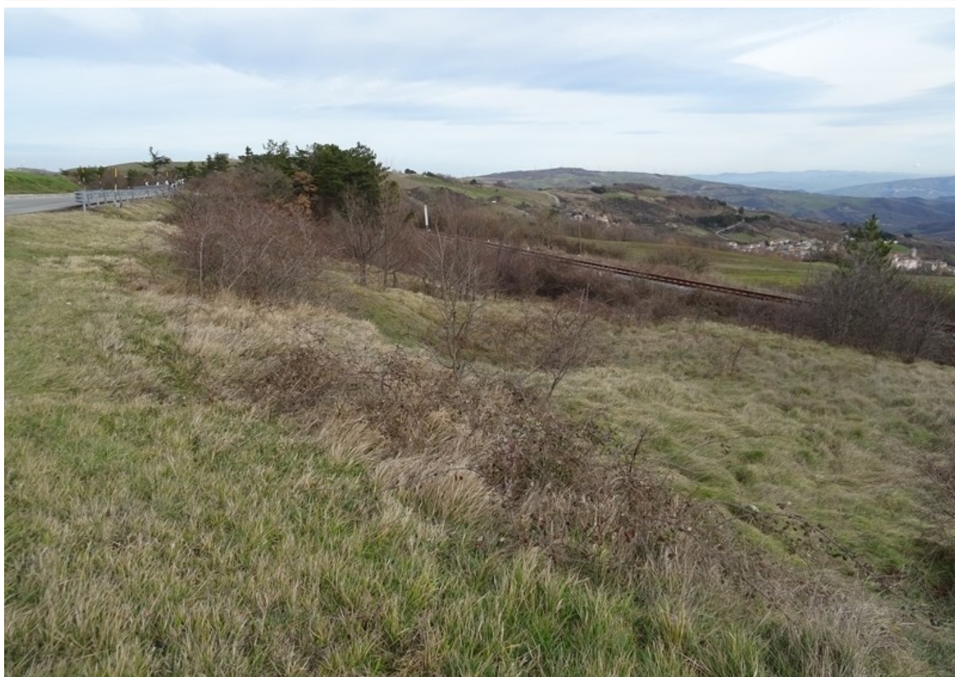
Foto 117 – Vista della nicchia della frana Fr_06, nel tratto compreso tra l'attuale S.S. 87 e la massicciata ferroviaria
