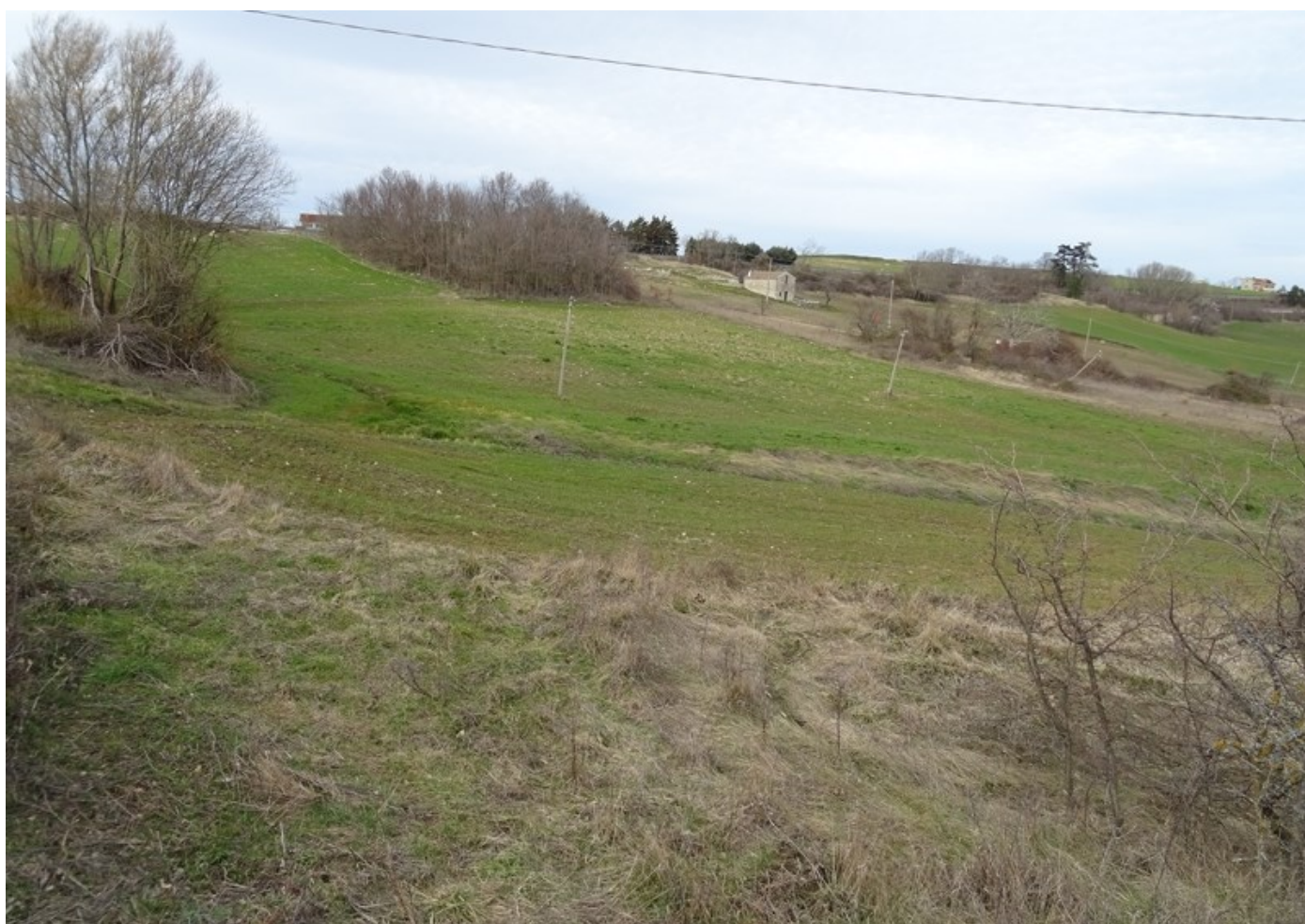
Foto 122 – Panoramica del versante a monte dei corpi di frana secondari della Fr_08. Diffusi fenomeni di creep evidenziati dai pali piegati in corrispondenza del futuro tracciato della S.S. 87 oggetto di variante
