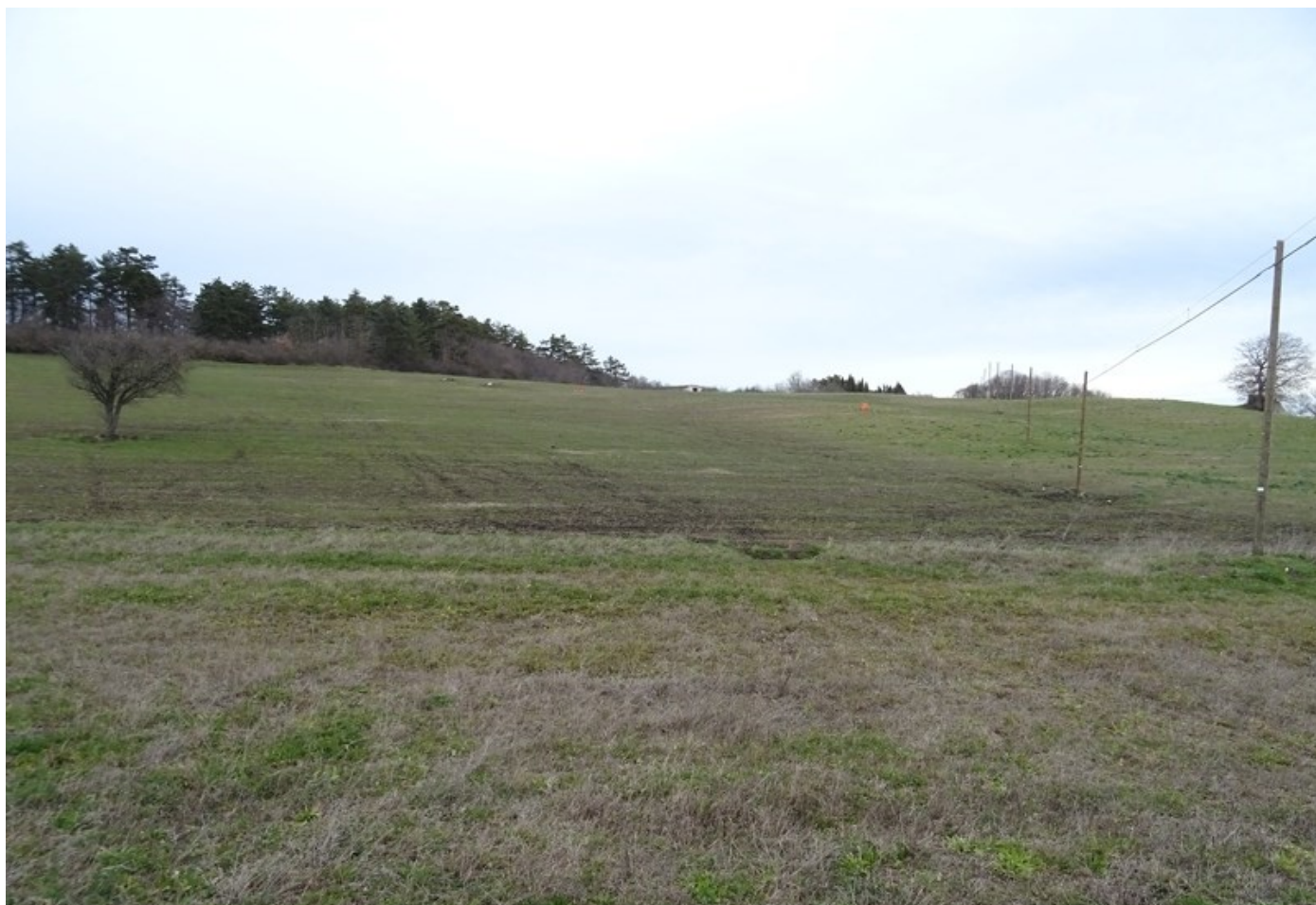
Foto 179 – Panoramica della frana Fr_11
