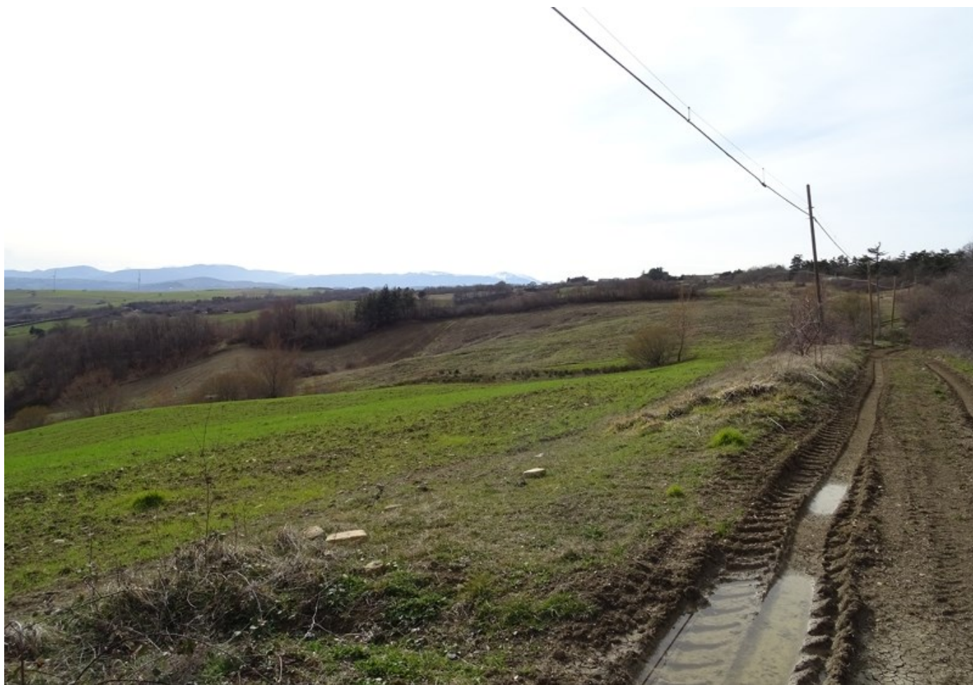
Foto 008 – Panoramiche frane Fr_2a-2b-c-d-3a-b
