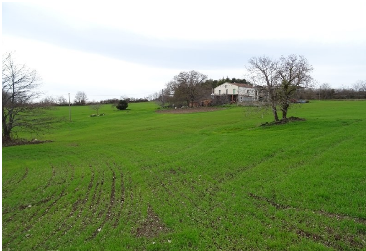
Foto 156 – Panoramica della nicchia della frana Fr_09
