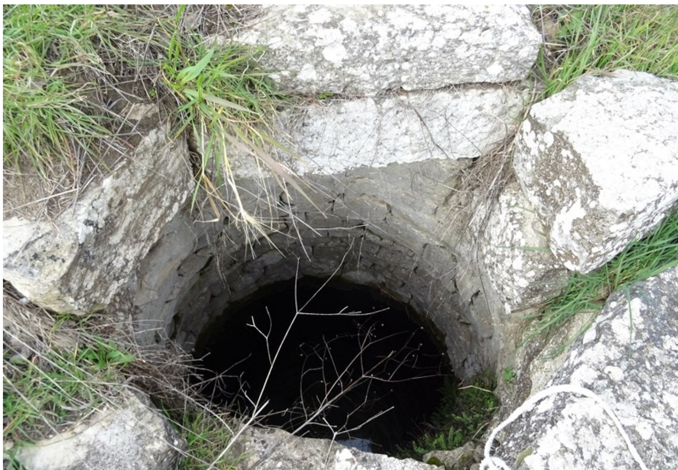
Foto 120 – Pozzo con soggiacenza a ca. -2.5m dal piano campagna
