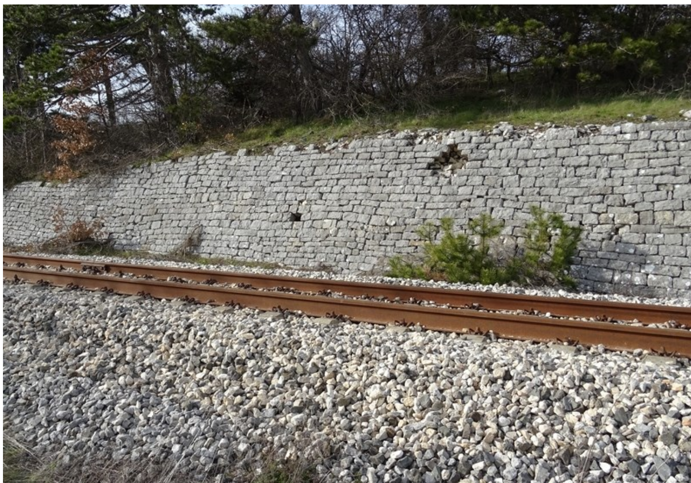
Foto 068 – Particolare della muratura di controripa a ridosso della ferrovia nei pressi della nicchia della frana Fr_04
