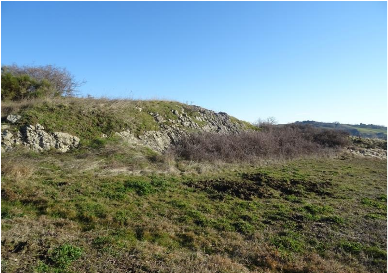
Figura 5 - Affioramento della successione lapidea in corrispondenza di una nicchia di frana
