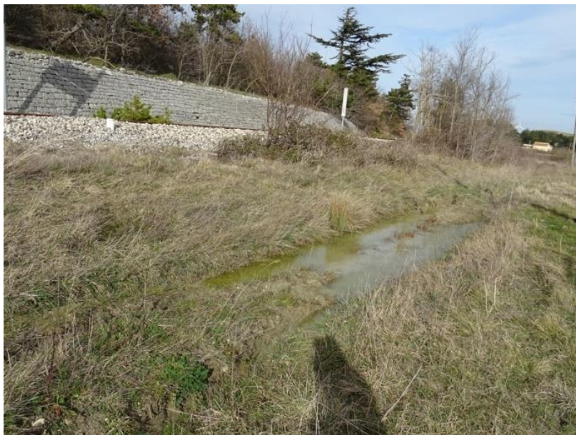
Figura 9 - Esempi di ristagni legati alla localizzata perdita di permeabilità dei depositi
