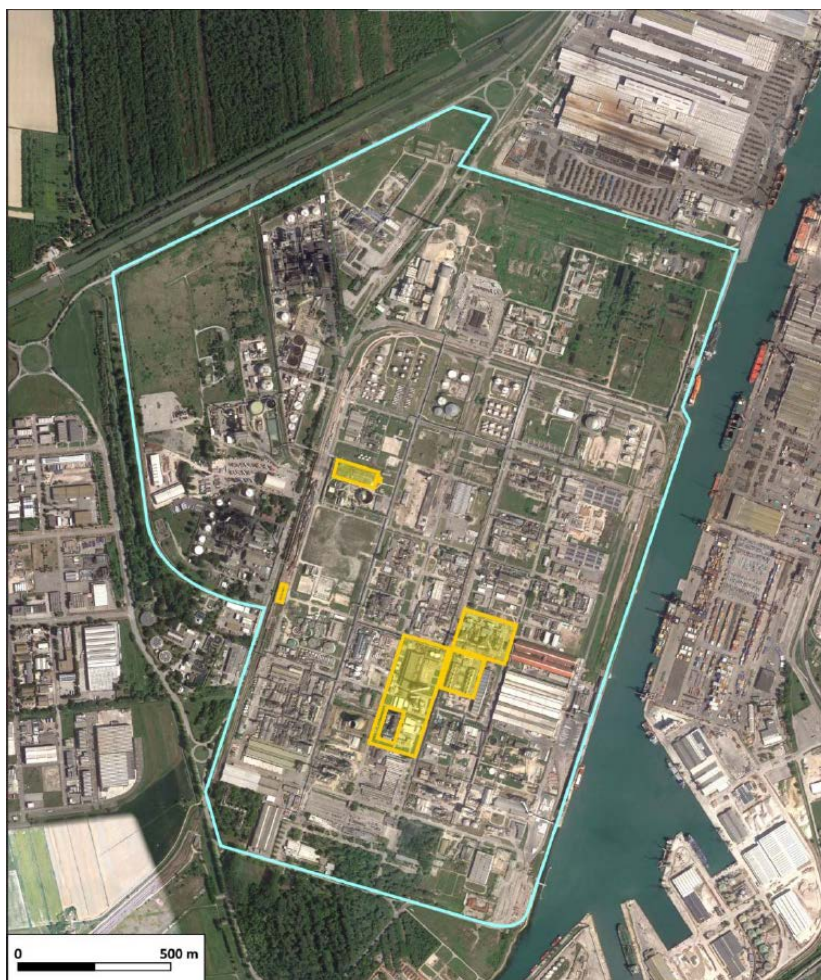
Figura 2.1 - Ubicazione delle aree interessate dal "progetto Peakers" di Ravenna -Sito petrolchimico multisocietario di Ravenna (linea azzurra) e Stabilimento Enipower (evidenziato in giallo)
