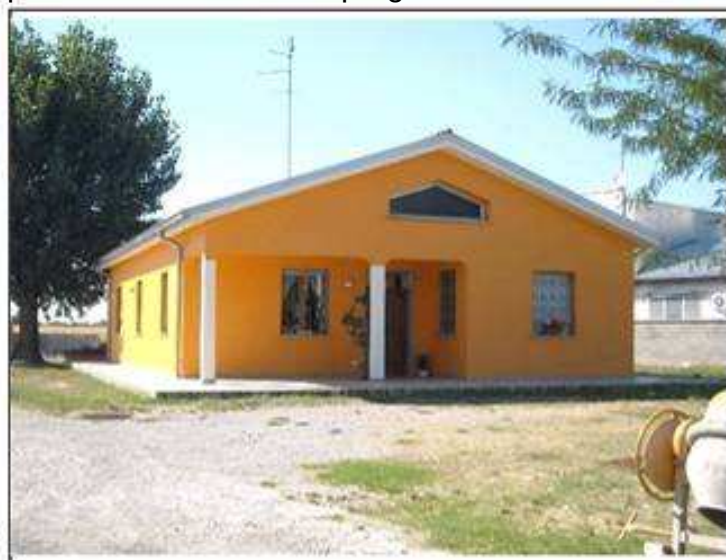
Vista da: Ovest
