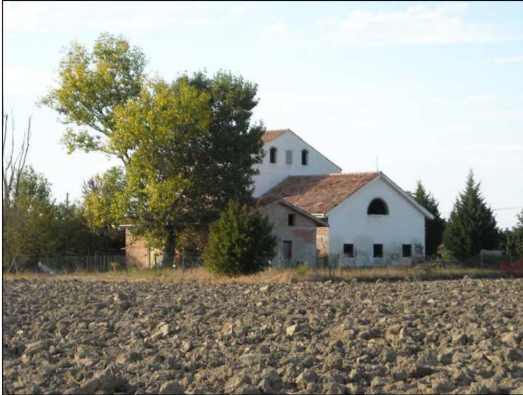
FIGURA 2.5-1 – RICETTORE BR022 – EDIFICIO PARZIALMENTE ABITATO, IN FASE DI AMPLIAMENTO E RISTRUTTURAZIONE
