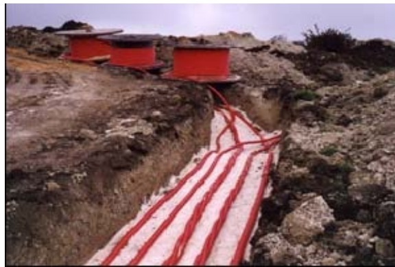
Posa cavidotto interrato
