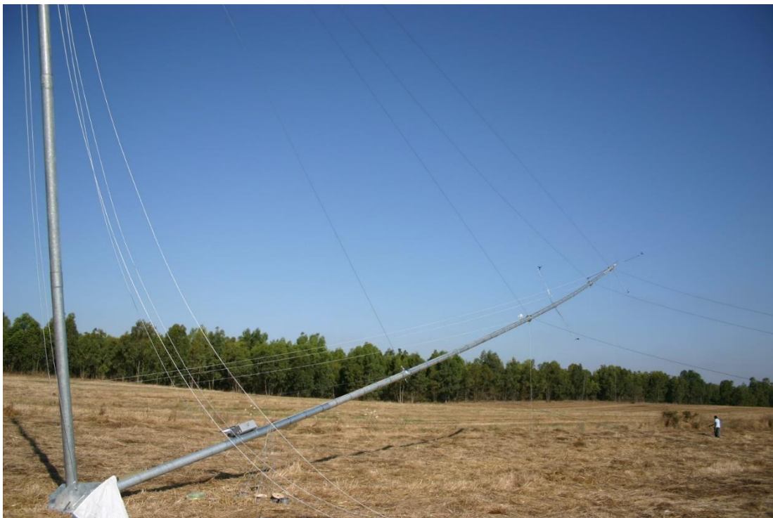
Figura n.1 - Installazione Anemometro
