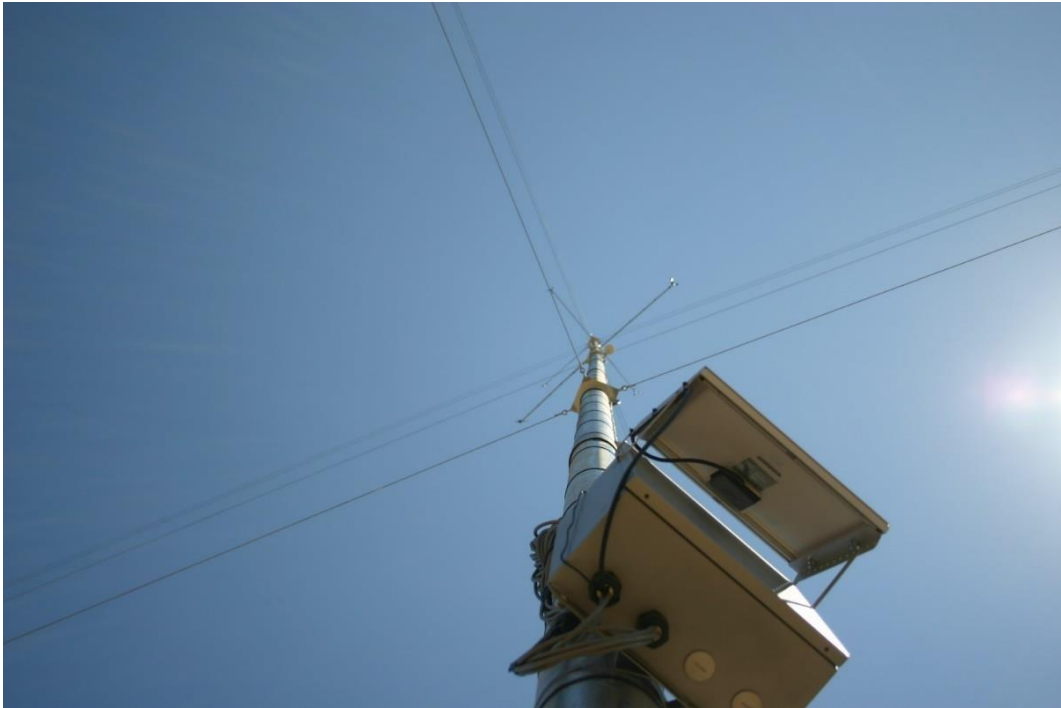
Figura n.2 - Istallazione Anemometro
