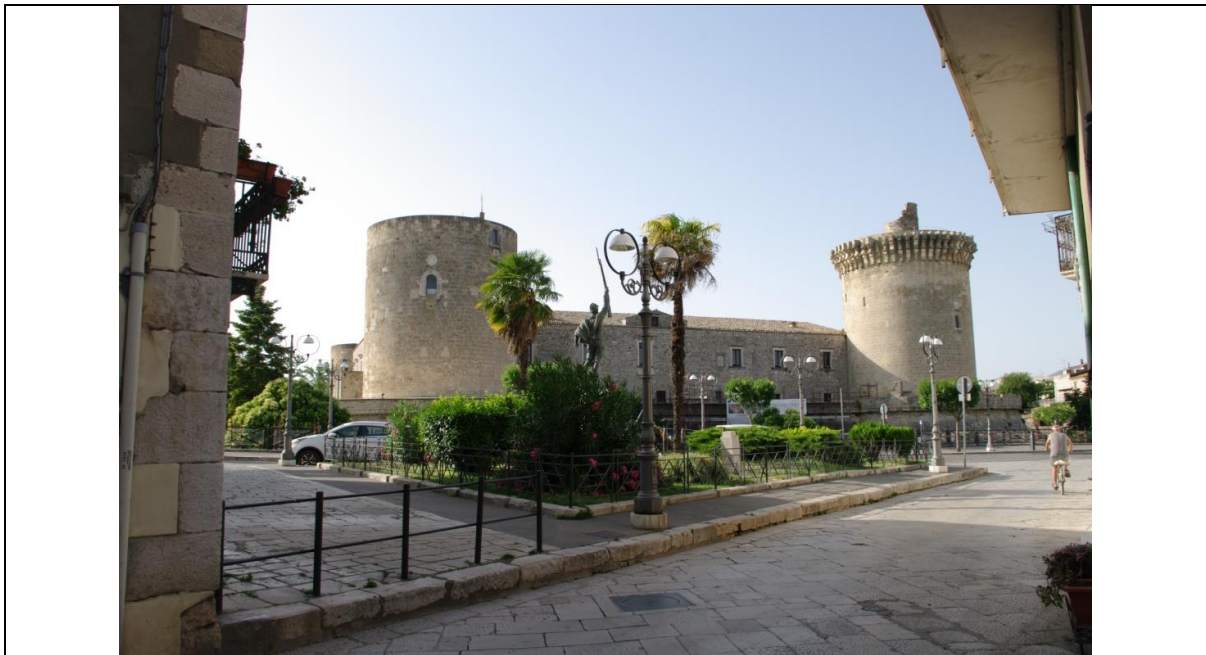
Figura n.48 – Vista del castello di Venosa
