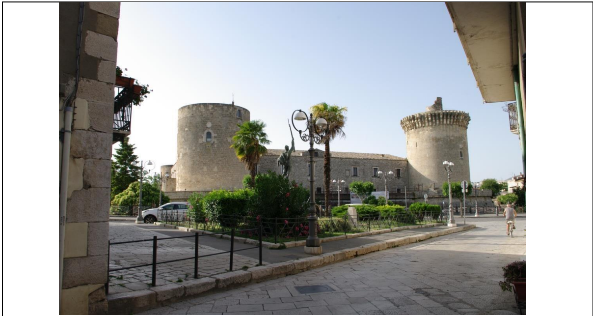
Figura n.48 – Vista del castello di Venosa
