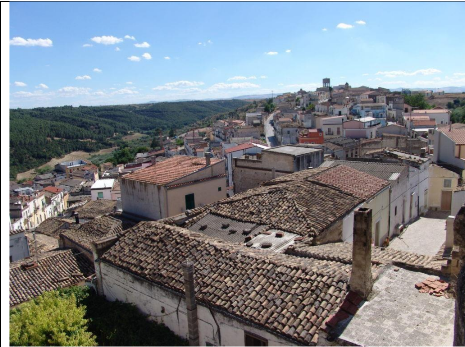
Figura n.54 – Vista del centro storico di Montemilone
