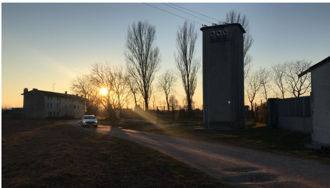
Foto 10 – Cabina Enel denominata “Cabina C.li Passeri”
