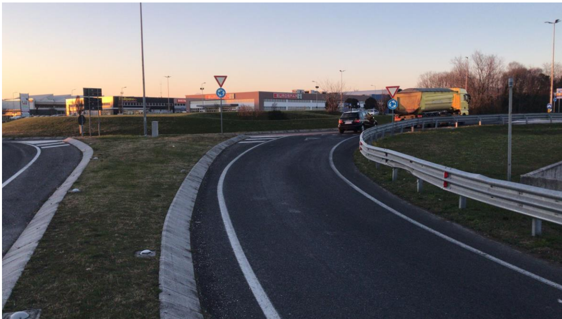
Foto 14bis - Strada Regionale SR464 (via Spilimbergo)
