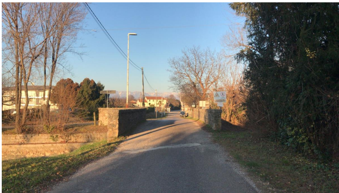
Foto 4 – Via Faugnacco – Attraversamento canale Ledra Tagliamento
