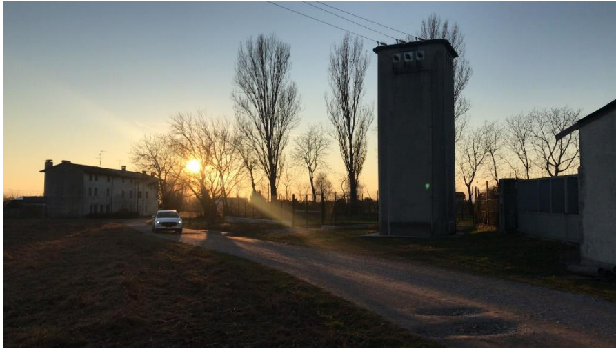
Foto 10 – Cabina Enel denominata “Cabina C.li Passeri”
