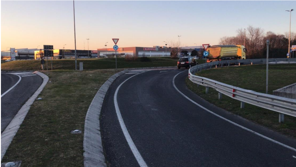
Foto 14bis - Strada Regionale SR464 (via Spilimbergo)
