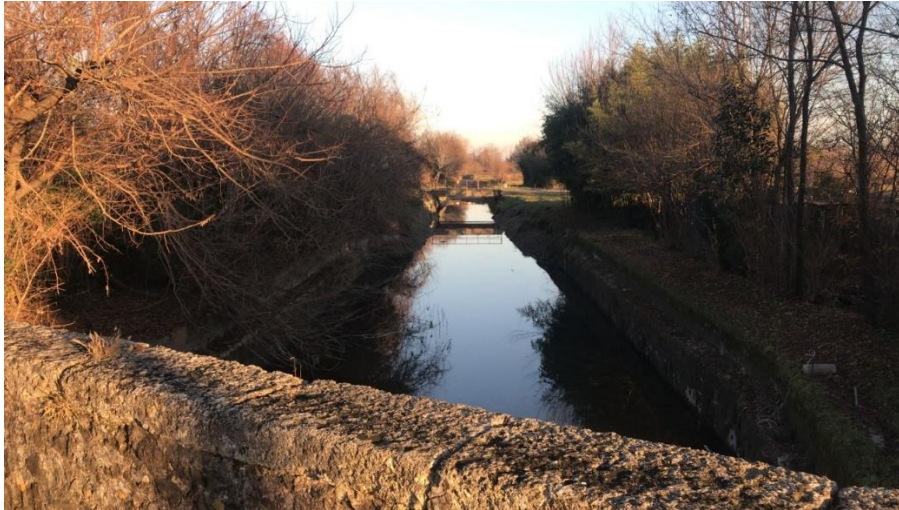
Foto 4 bis – Via Fagnacco – Attraversamento canale Ledra Tagliamento
