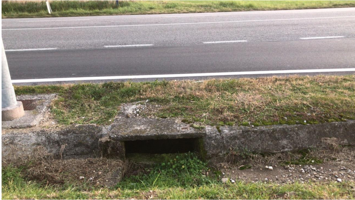
Foto 17bis – Strada Regionale 464 (via Spilimbergo) - Attraversamento tombino stradale
