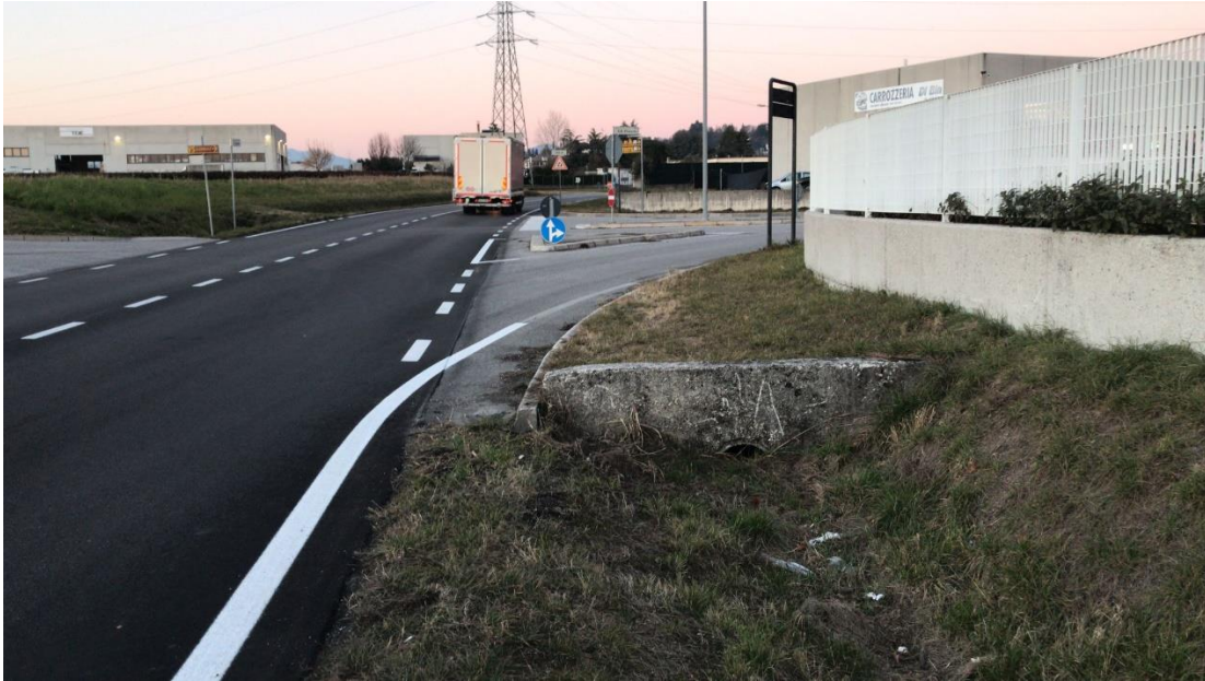
Foto 18bis – Via Angelo Tonutti - Attraversamento condotta idrica interrata
