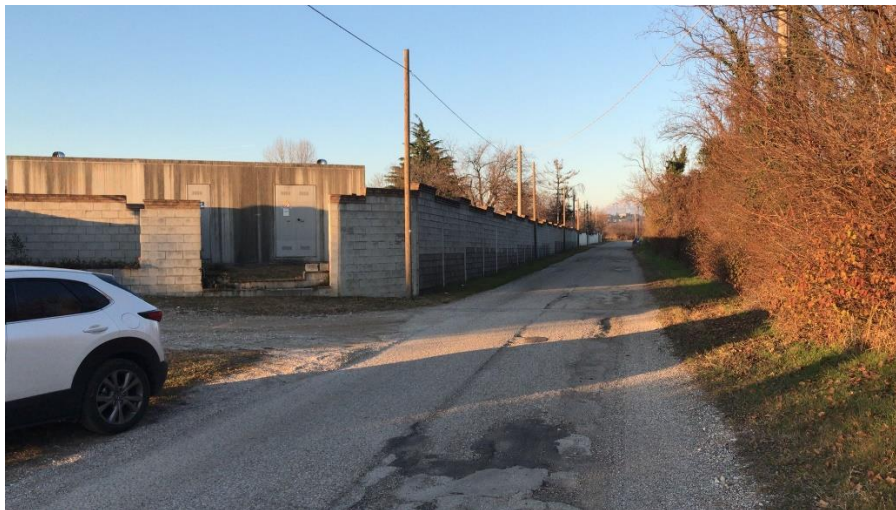
Foto 8 – Via Molini sul Ledra – Ingresso Cabina Enel denominata” Cabina FVT Dadj Club”
