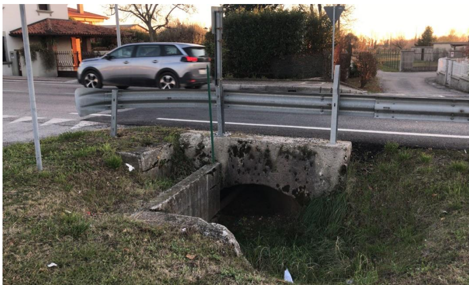
Foto 12bis- Strada Regionale SR464 (via Spilimbergo) - Attraversamento canale di scolo
