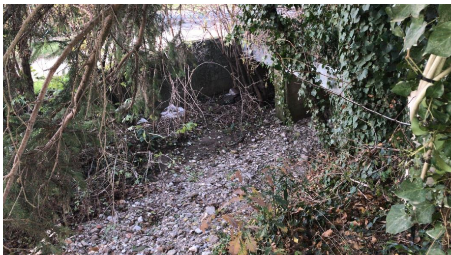
Foto 15bis - Strada Regionale SR464 (via Spilimbergo) – Attraversamento canale di scolo
