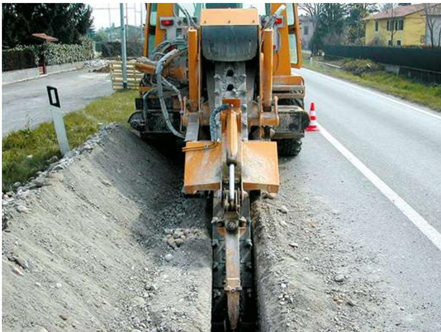
Figura 8-7. Esempio di mezzo di piccole dimensioni per la realizzazione dello scavo per la posa del cavidotto.
