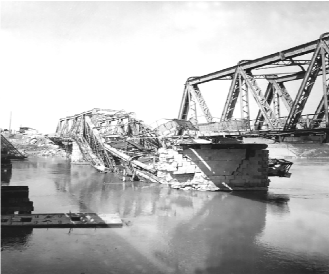
Foto 5: Ponte stradale distrutto dai bombardamenti
