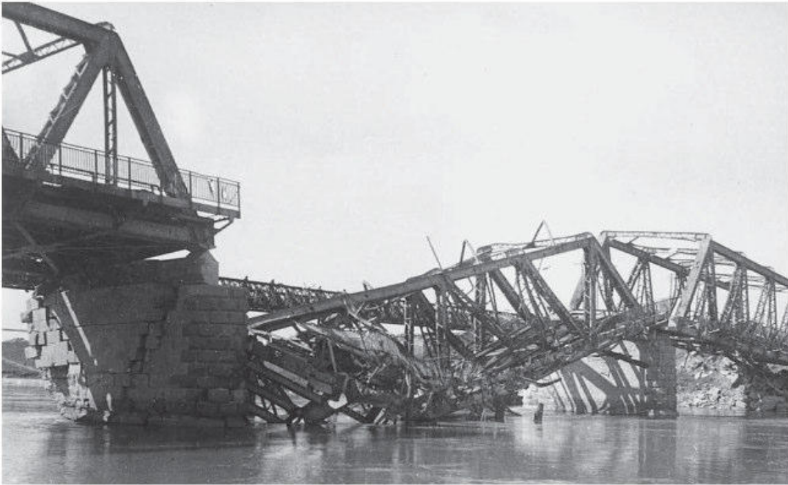
Foto 4: Ponte stradale distrutto dai bombardamenti
