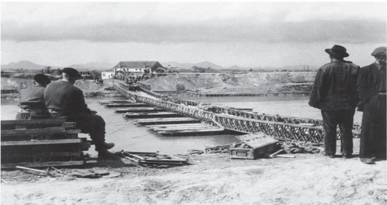
Foto 3: Attraversamento provvisorio sull'Adige a Boara (localizzato circa 300 metri a est dell'attuale ponte) il 29 aprile 1945.
